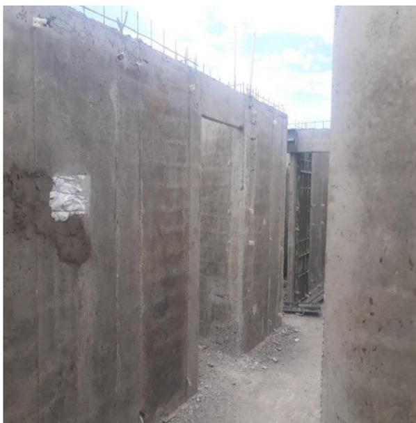
**Figura 9. Muros fundido, fraguado y desencofrado**
