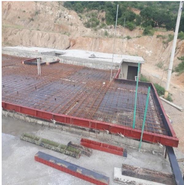
**Figura 11. Armado de formaleta metálica para placa**
