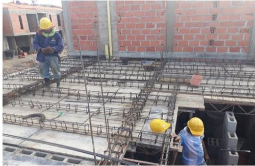
**Figura 5. Armado de formaleta para placa aligerada**
