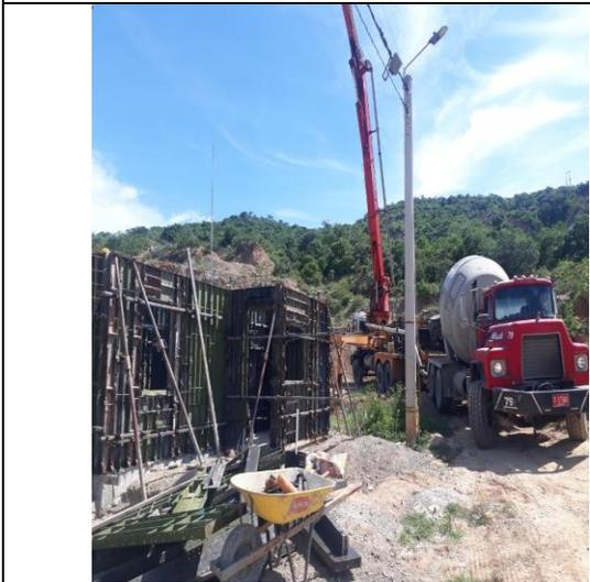
**Fundida de muros concreto 3000psi**
