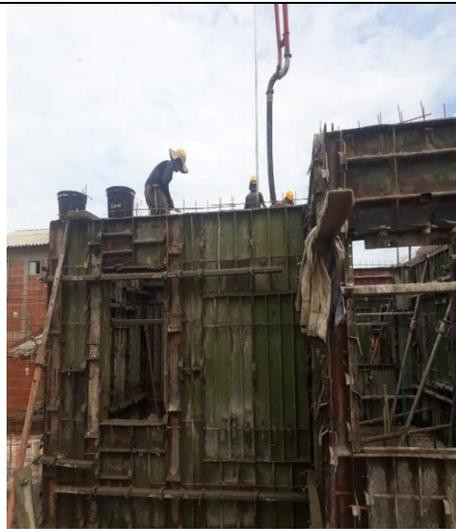
**Fundida de muros concreto 3000psi**
