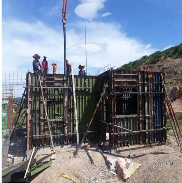
**Figura 10. Armado de formaleta metálica para muro**
