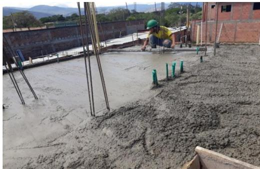
**Figura 7. Fundida placa de aligeramiento**
