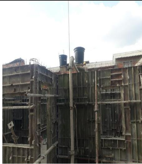
**Fundida de muros concreto 3000psi**
