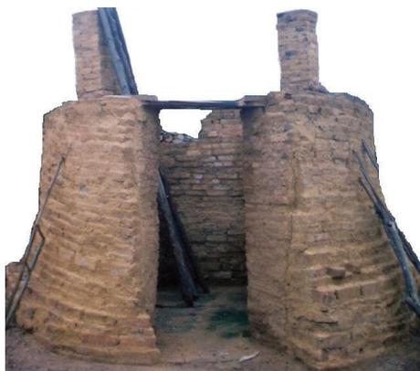
**Figura 1.3.** Horno de pared de ladrillo y barro con aberturas en la parte inferior, utiliza madera como combustible. (Sector Los Hornos, Estado Táchira, Venezuela)
