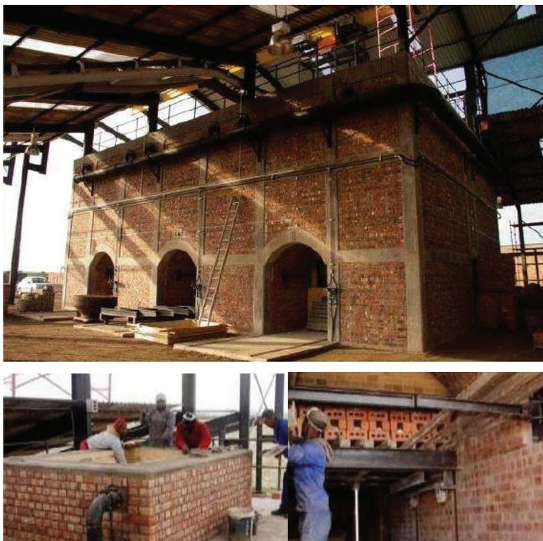
**Figura 3.11.** Horno vertical producido bajo el auspicio de Swisscontact Sudáfrica <sup>[12]</sup>.
