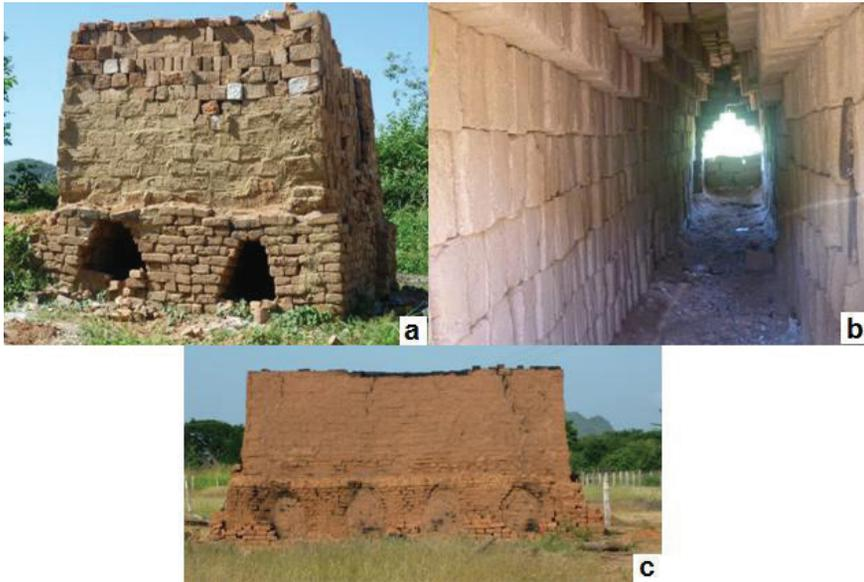
**Figura 1.4.** a) Horno de fuego dormido que utiliza madera como combustible, b) Cámara del horno, c) Horno cargado y en procesos de enfriamiento (Hornos ubicados en el Departamento del Cesar, Colombia, fotos cortesía del Cimac/UFPS)
