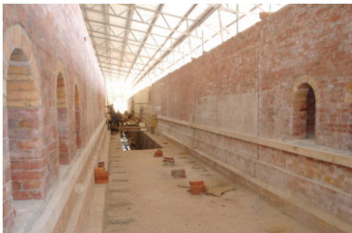
**Figura 6.23.** Interior de un horno Túnel en construcción, Cortesía de Maquilob, Maquinaria para cerámica.
