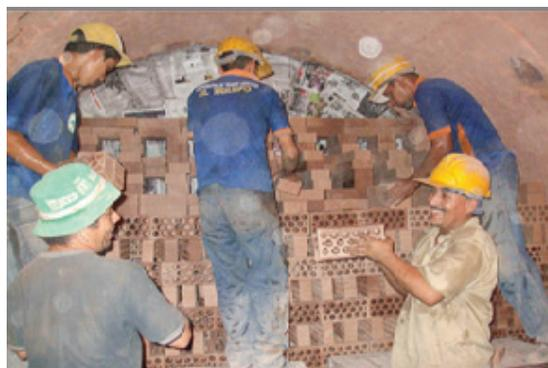
**Figura 6.20.** Cargue de cámara del horno Hoffman en una empresa de la región <sup>[8]</sup>. Foto cortesía del Cimac-UFPS.
