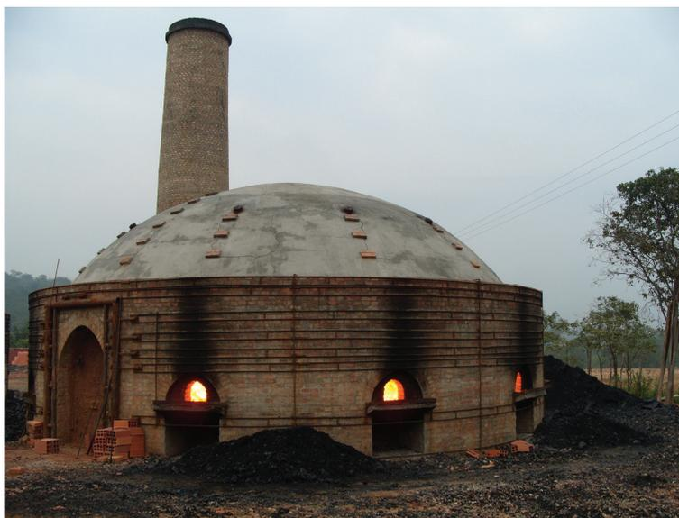
**Figura 1.9.** Horno tipo colmena a carbón de la Empresa Cerámica Murano S.A [7]
