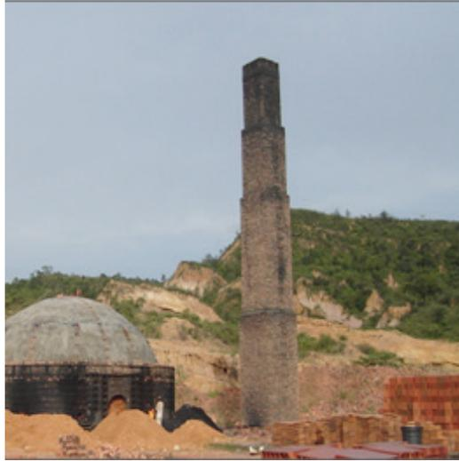
**Figura 6.13.** Tipos de chimeneas utilizadas en los hornos colmena.
