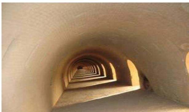
**Figura 6.18.** Interior de un horno Hoffman en proceso de construcción<sup>[7]</sup>.
