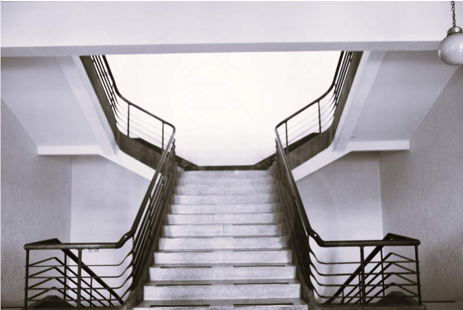
Figura 46. Escalera principal del Edificio Santander (vista frontal)
