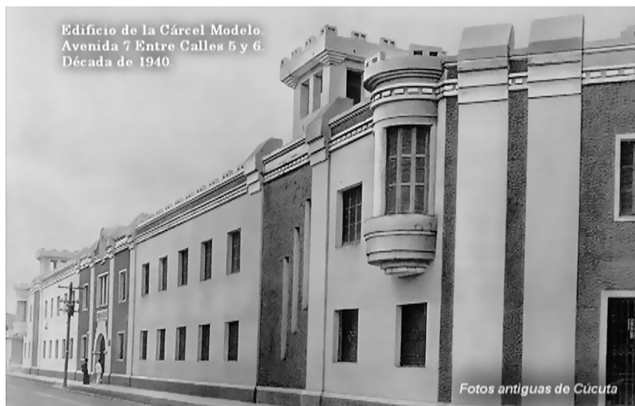
Figura 6. Edificio de la Cárcel Modelo, avenida 7ª entre calles 5ª y 6ª (década de los cuarenta)
