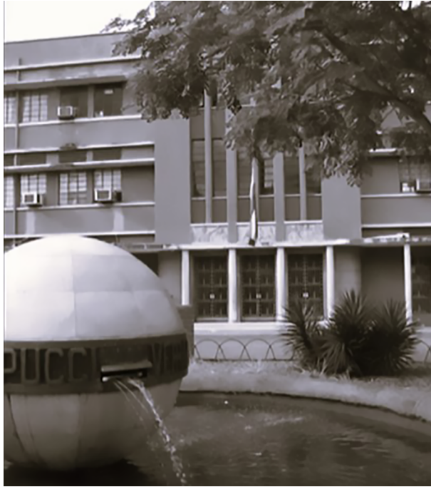
Figura 43. Entrada del Edificio Santander y la fuente de los descubridores
