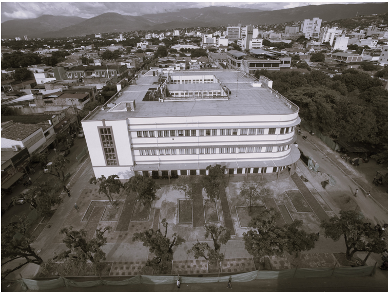
Figura 28. Vista aérea lateral del Edificio Santander
