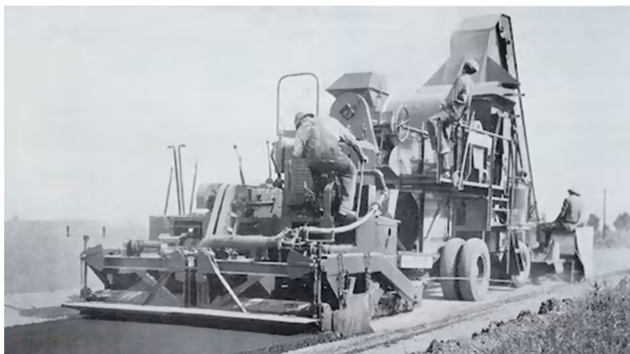
Figura 49. Maquinaria usada por la Barber Asphalt Corporation para la pavimentación de vías
