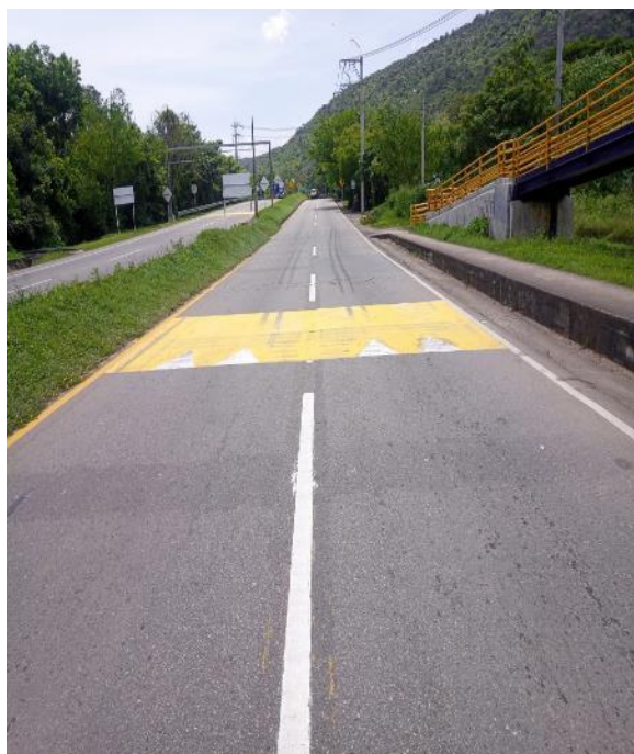
Figura 16. Vista General del tramo.
