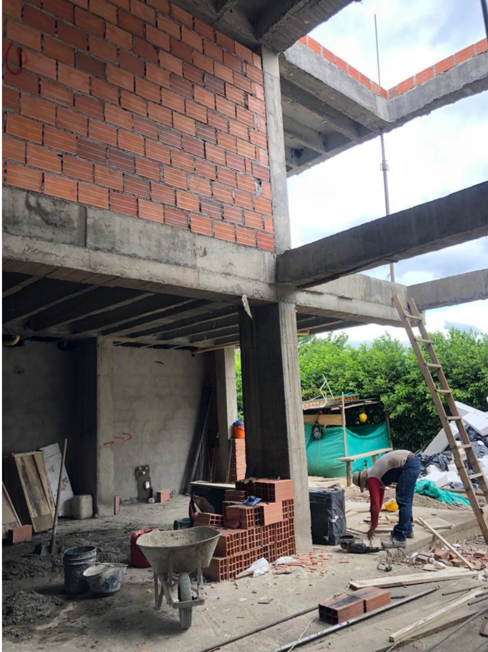
Foto No.3 Mampostería Primer Piso
