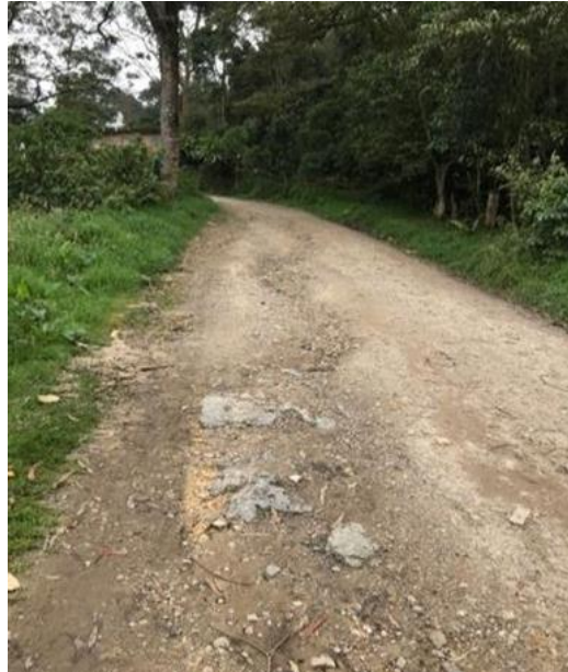
Estado del afirmado
