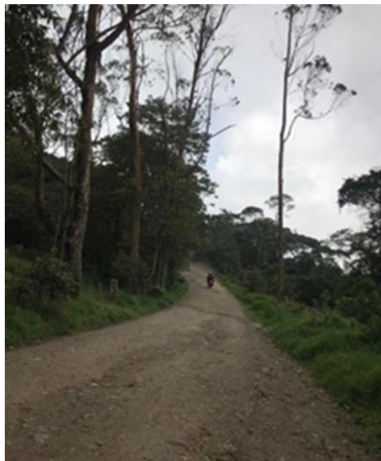
Afirmado en buen estado
