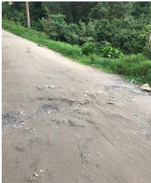
Estado del afirmado
