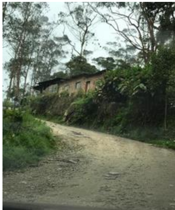
Afrimado en mal estado
