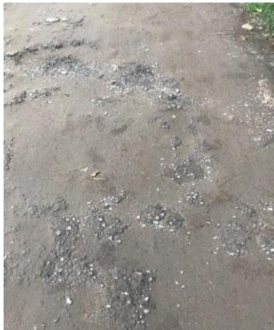
Estado del afirmado
