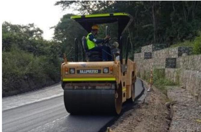
*Figura 12. Vibro compactadora.*
